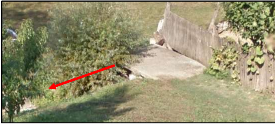
Slika 2.1-4. Postojeći betonski propust na koritu potoka Kustošak u stac. km 6+625,00, s označenim smjerom tečenja (izvor: Viacon, 2019. )
